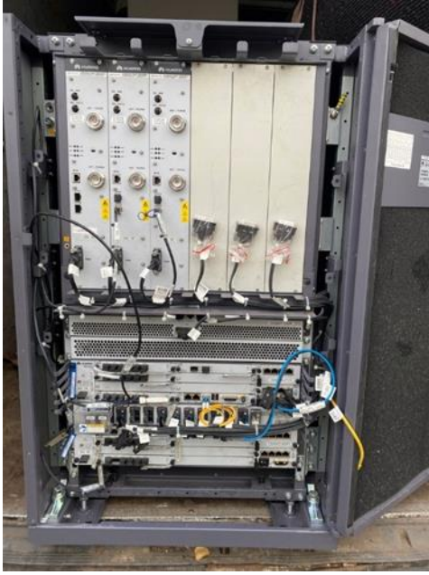
الشكل (2-3) مكونات محطة التغطية الخلوية
