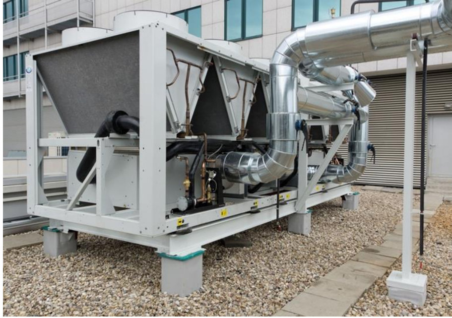
الشكل (2-5): وحدة تكييف مركزية Chiller
