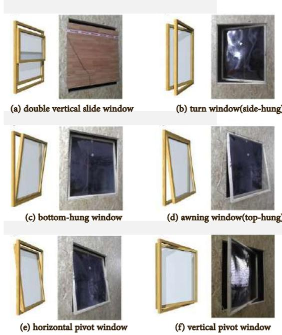
شكل(2-23): أنواع النوافذ التي فحصها, von Grabe et al.,
