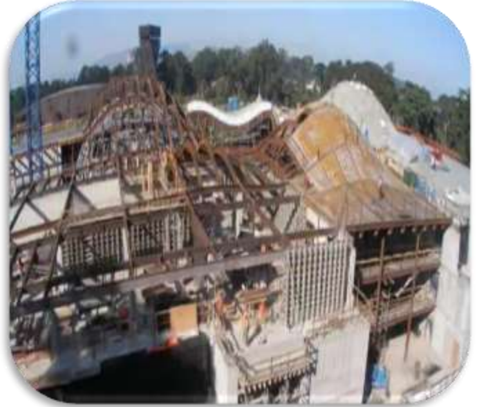
الشكل: (19) جوائز المعدنية في سقف المبنى
