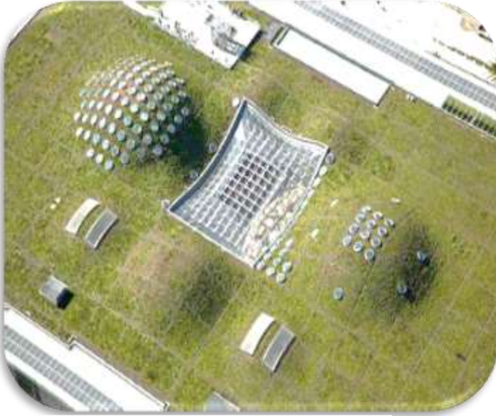
الشكل: (24) يوضح السقف الأخضر للمبنى
