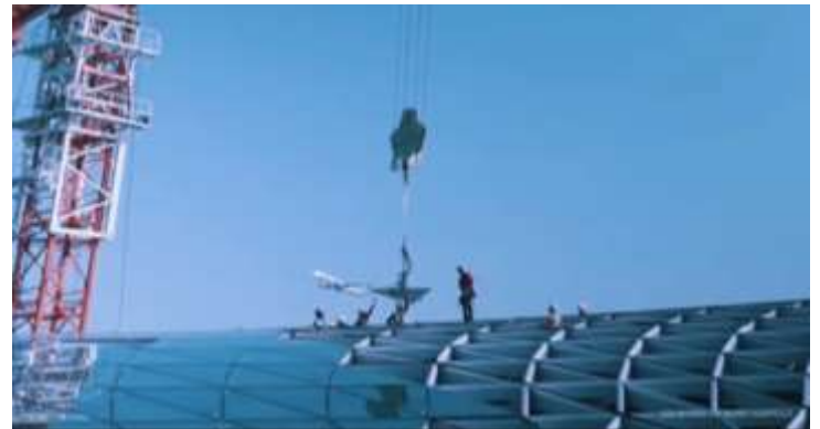
الشكل: (35) يوضح تغليف الألواح الجوائز الشبكية بالألواح الزجاجية
