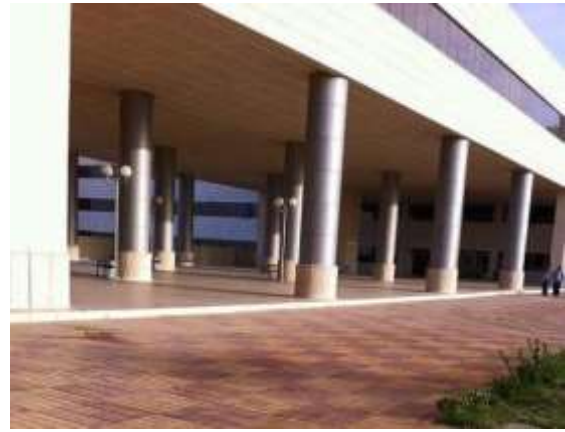
الشكل: (61) مبنى كلية الهندسة المعمارية من الخارج
