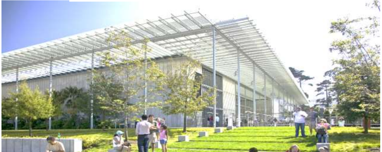
الشكل: (22) يوضح الخلايا الكهروضوئية على أطراف المبنى
