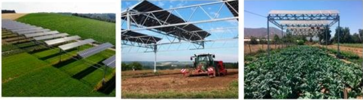
الشكل (7): تركيب مصفوفات كهروضوئية للزراعة تحتها في ألمانيا وتشيلي [30]
