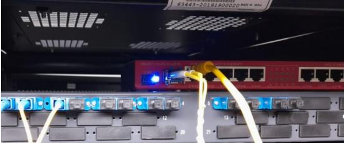
الشكل(9-3)-توصيل راوتر المايكروتيك مع ODF داخل الفندق
