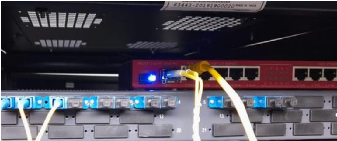
الشكل (12-3)-توصيل راوتر المايكروتيك
