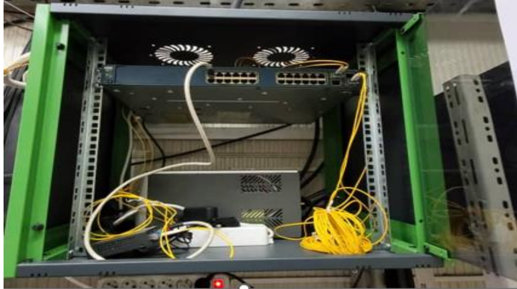
الشكل (3-5) - توصيل Switch في المقسم
