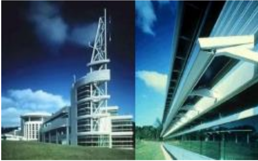
الشكل رقم ( 12 ) يبين الكاسرات الكهروضوئية بزاوية ميل في مركز البحوث جامعة نيويورك .
