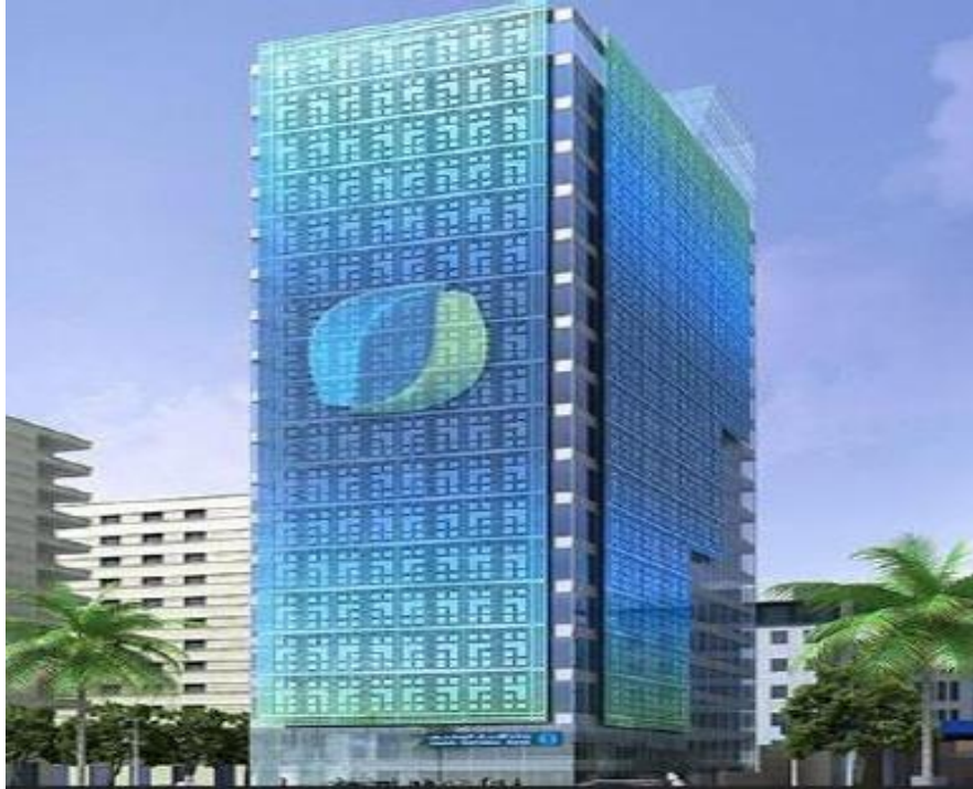
الشكل رقم ( 26 ) يبين واجهة مبنى بنك الاتحاد الوطني المصري المغطى بالزجاج الكهرضوئي
