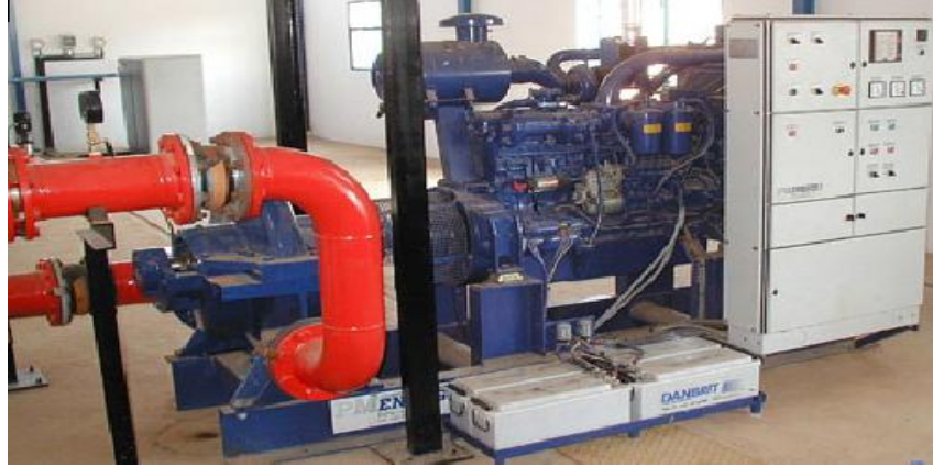
الشكل (3-6) نظام الإطفاء بالماء
